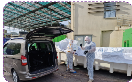
Collecte ponctuelle amiante
